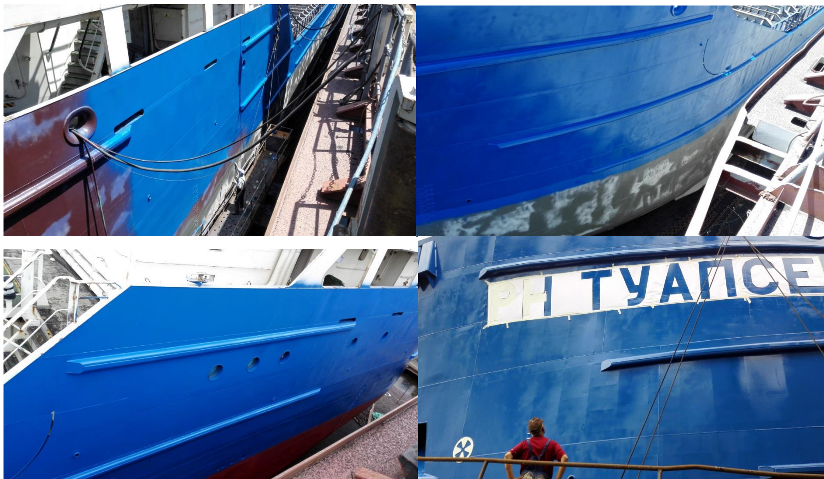
Фото: Нанесение финишного покрытия «Акрус-Полиур» (надводный борт)
