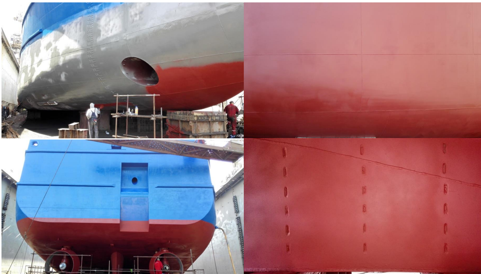
Фото: Нанесение противообрастающего покрытия «Акрус-042М»
